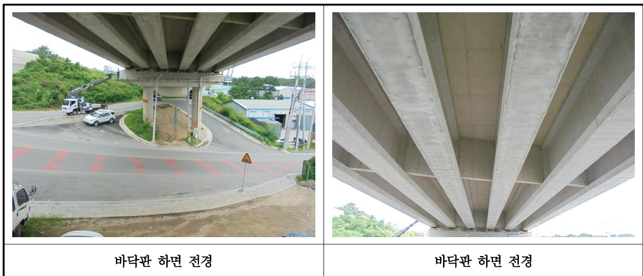
【사진 30.3.2】 바닥판하면 전경
