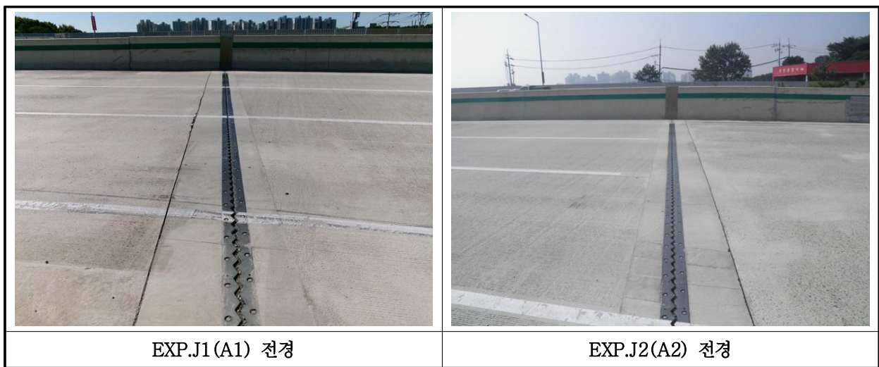
【사진 30.3.16】 신축이음장치 전경
