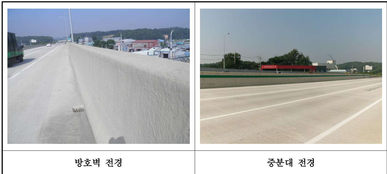
【사진 30.3.23】 방호벽 및 중앙분리대 전경
