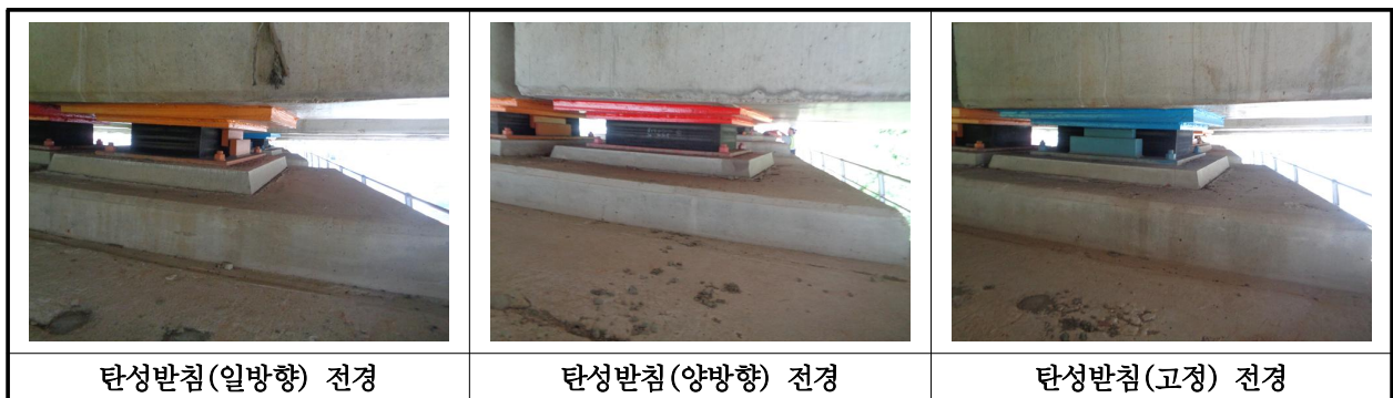
【사진 30.3.12】 교량받침 전경
