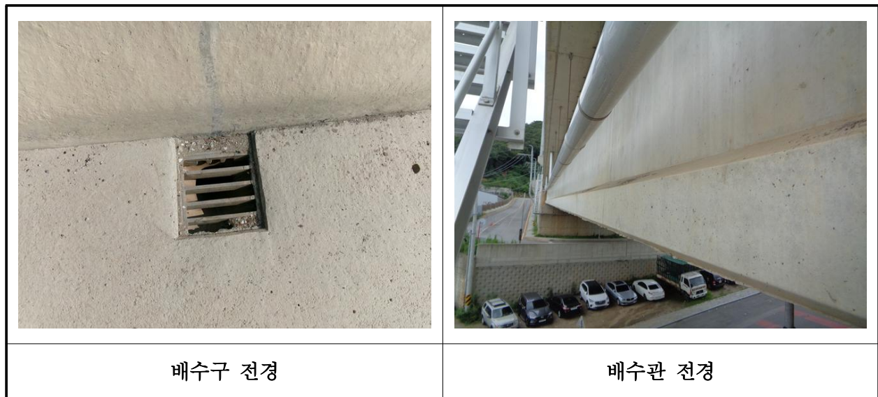
【사진 30.3.21】 배수시설 전경
