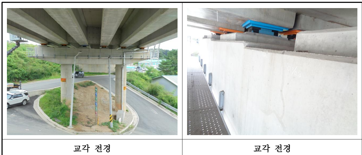
【사진 30.3.10】 교각 전경
