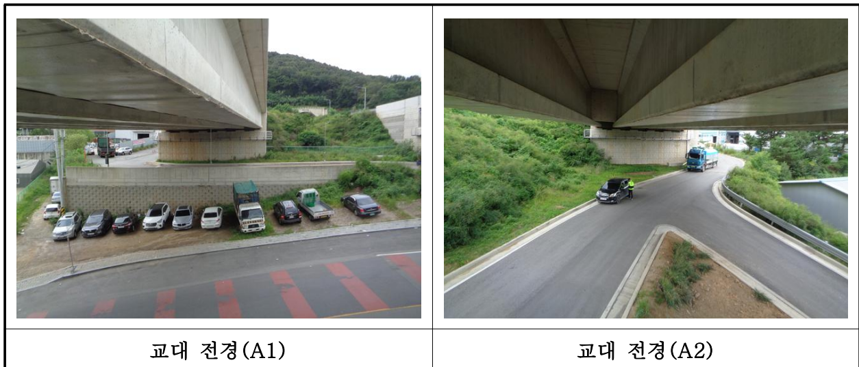
【사진 30.3.8】 교대 전경
