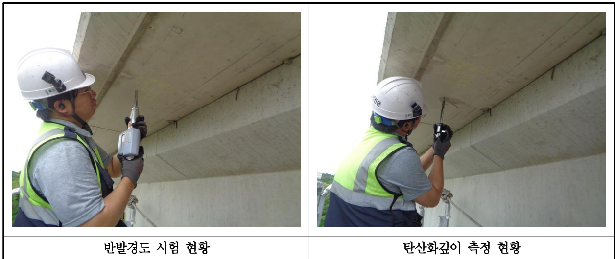
【사진 30.4.1】 콘크리트 내구성조사 현황
