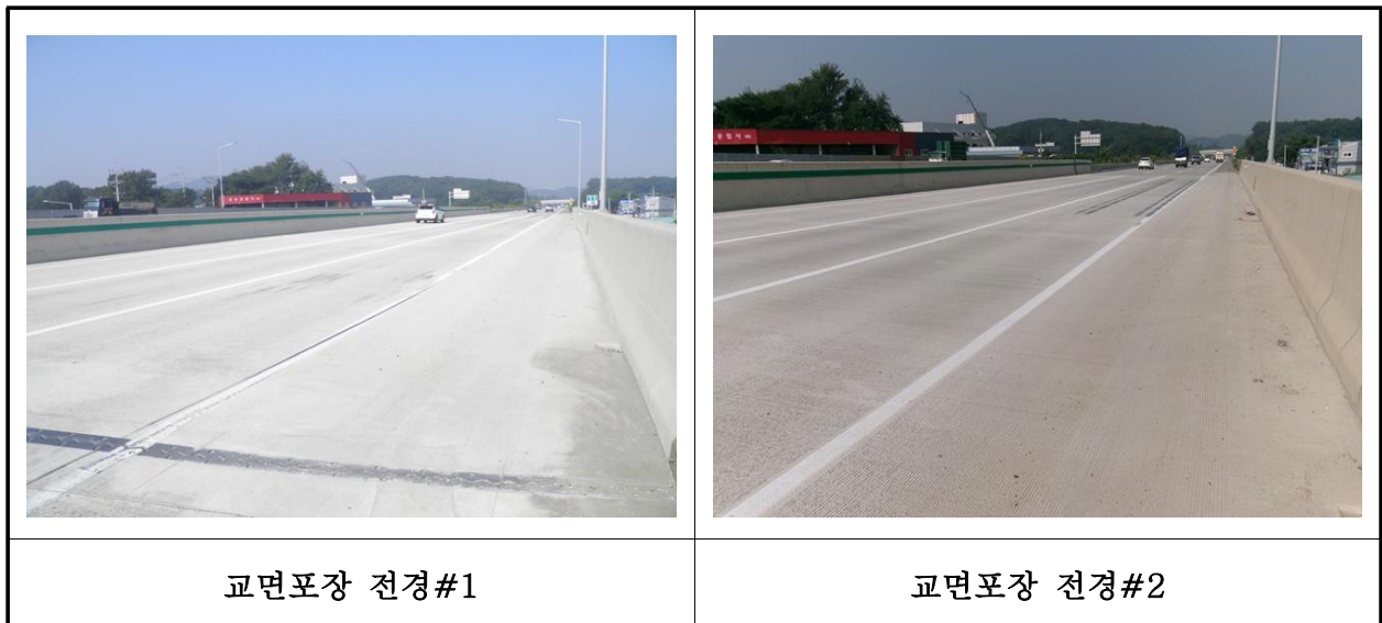
【사진 30.3.19】 교면포장 전경
